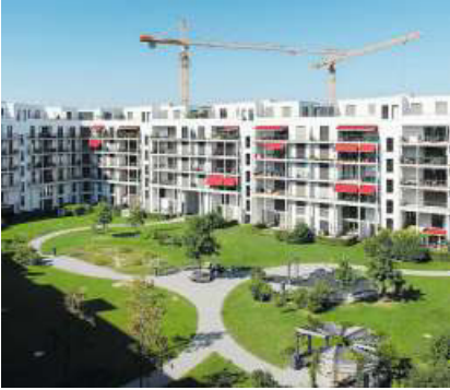
Öffentlicher Innenhof in Wallisellen.
